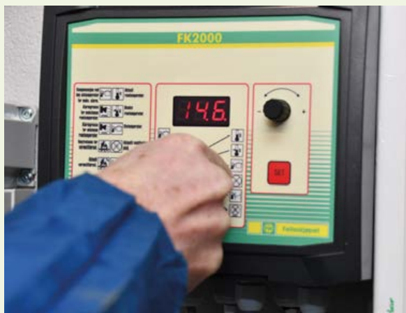
Jan Håkon anbefaler enkel styringsenhet som FK 2000. Han justerer ned temperaturen fra 14,6 til 11 grader for å få et bedre klima i fjøset. P-båndet er «slingringsmonnet» i styringen, og det bør ikke være for stort. Ved p-bånd 1 og temperaturinnstilling 12 vil styringen prøve å holde temperaturen mellom 11 og 13.
