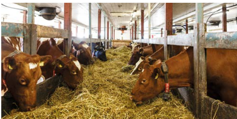
Det er stor forskjell på å montere el-utstyr i ett tørt og rent industrilokale eller kontorbygg, sammenlignet med husdyrrom fullt av syrer og gasser og med et konstant fuktig klima. Foto: If
