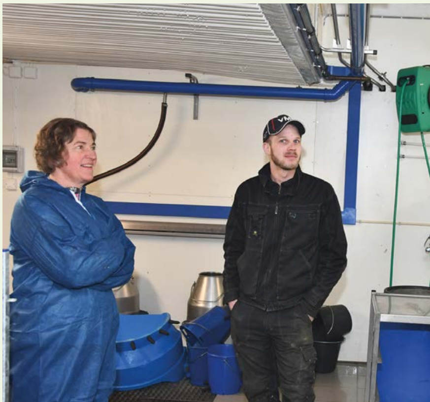
Grete Nesteby, Mats Ola Brydalseggen og Jan Håkon Jordet diskuterer ventilasjon og her på overgangen mellom nytt og gammel er det noen utfordringer.
