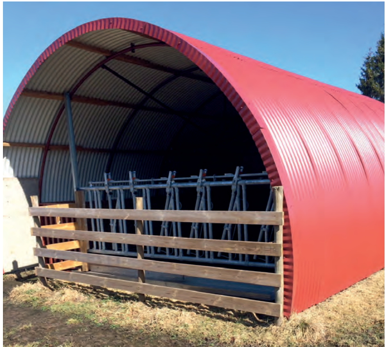
Rundbuehall med fanghekk. Stengt i forkant slik at dyra må gå inn for å ete. Foto: Privat
