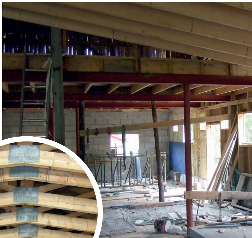
↑ Kontroll av forankringer og avstivninger må gjøres før konstruksjonene blir innkledd. Foto: Per Olav Skjølberg, NLR
