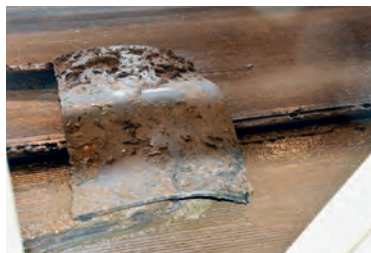
I nyfjøset er det spaltegulv og kanalorøring, mens det i ungdyrfjøset er faste gulv og skrap. Gummimatte monteret over skrapen gir kyrne et varsel og forebygger beinskader.
