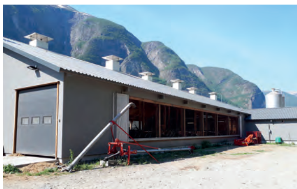
Fjøsene har naturleg ventilasjon. Lufta kjem inn gjennom opninga på langsiden, og gammal luft vert sugd ut gjennom pipene i taket.
