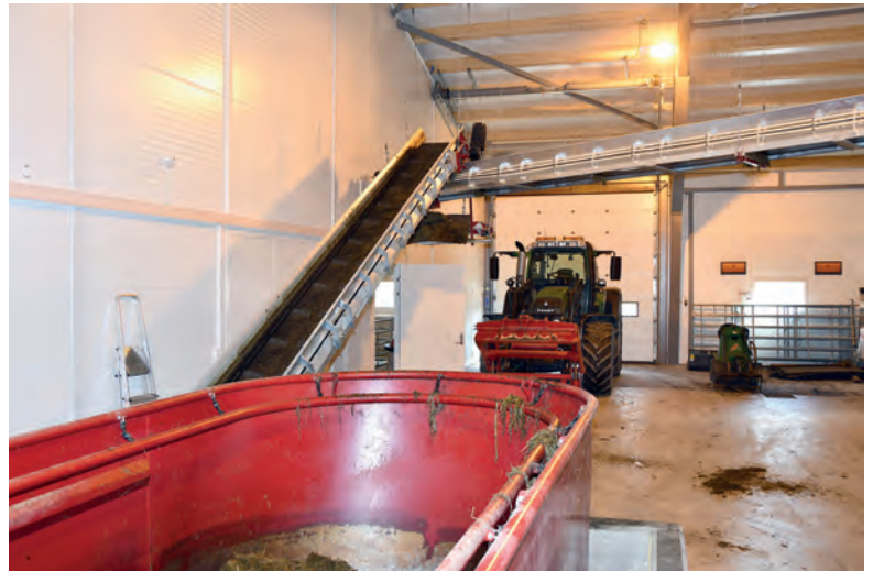
BvL fullformikser (25 kubikkmeter) og båndutføring til både ungdry- og kufføs.
