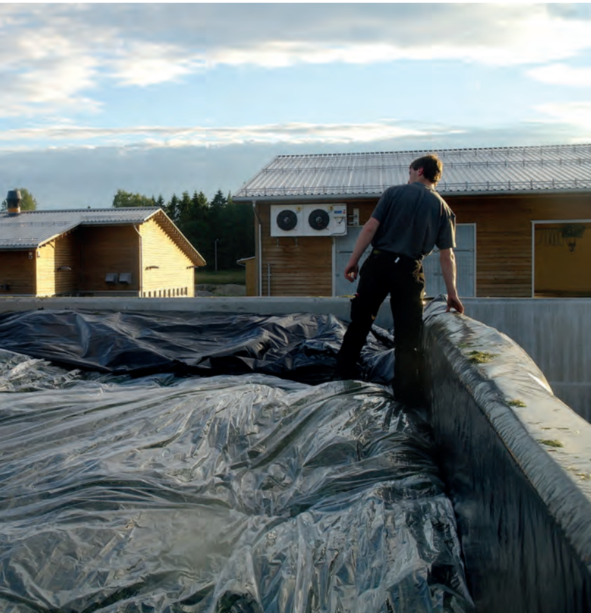
Plast opphengt på ende- og sidevegg brettes inn over tynn plast som er presset ned mellom gras og silovegg. Foto: Åshild T. Randby
