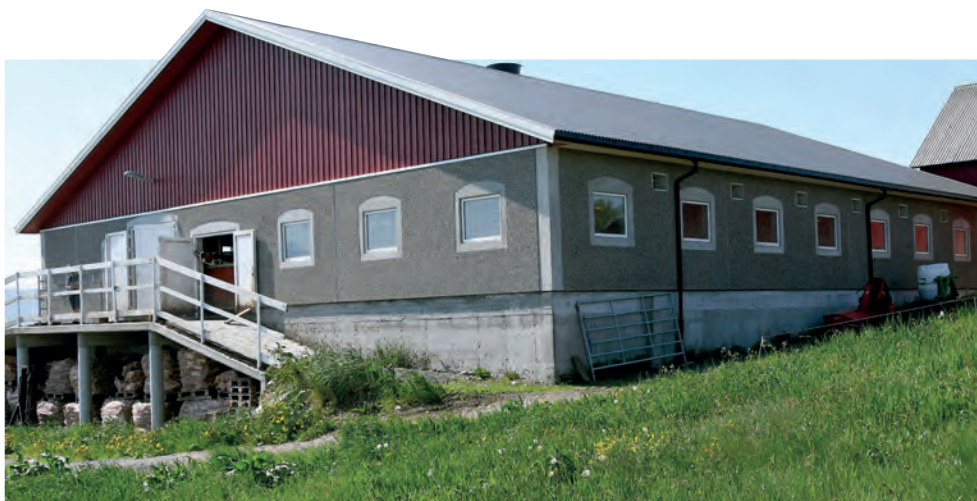
Tilbygg med kjeller under hele bygget. Den åpne dora viser veien ut til beite og under ble det overbygd vedlager.
