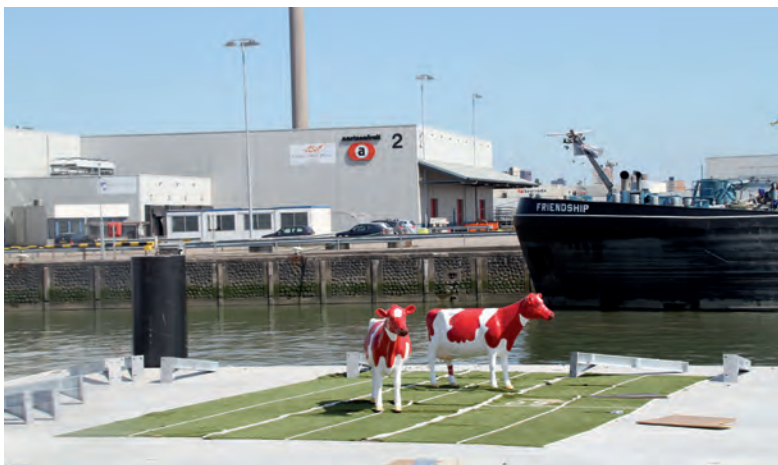
Selve flåten bygges i betong men flyter. Den takler både jordskjelv, storm og høyvann.
