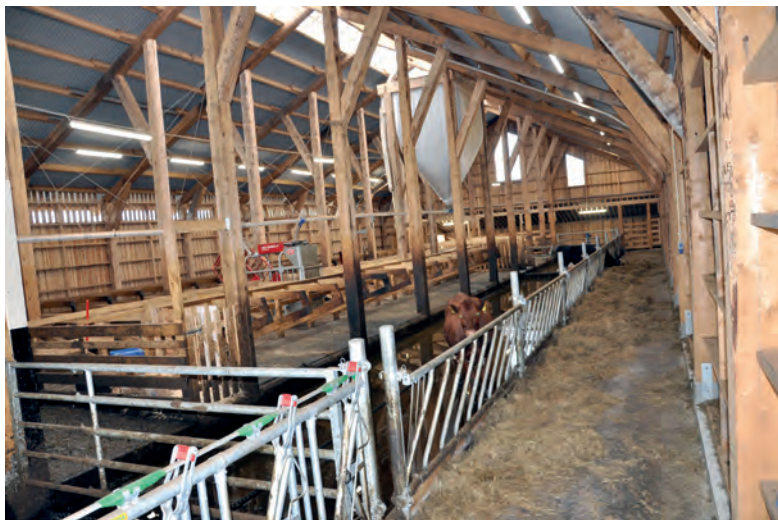
Fôrbrettet med pussa betong ligger mot yttervegg. Rundballer kjøres inn med bobcat og rives underveis. Stålgrinda mot fôrbrettet er eneste store stålelement i fjøset.
