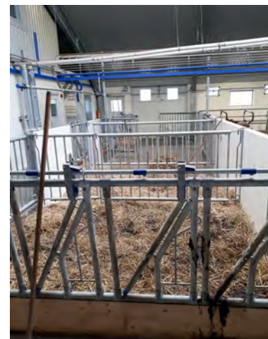
Fjøsene har fem kalvingsbingar med tett golv som vert dekkja med rikeleg med halm. I bakkant er det ein stor port i yttervegg slik at ein kan komma til med traktor og lesseapparat for å byta ut halmen med gjevne mellomrom.
