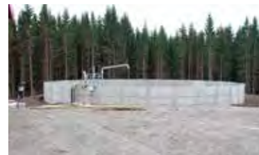
Gjødselkum vil legge beslag på mer areal enn møkkjeller, men både plassering av kummen og planlegging av adkomstvei påvirker hvor mye matjord som beslaglegges. Foto: Jan Arve Kristiansen
