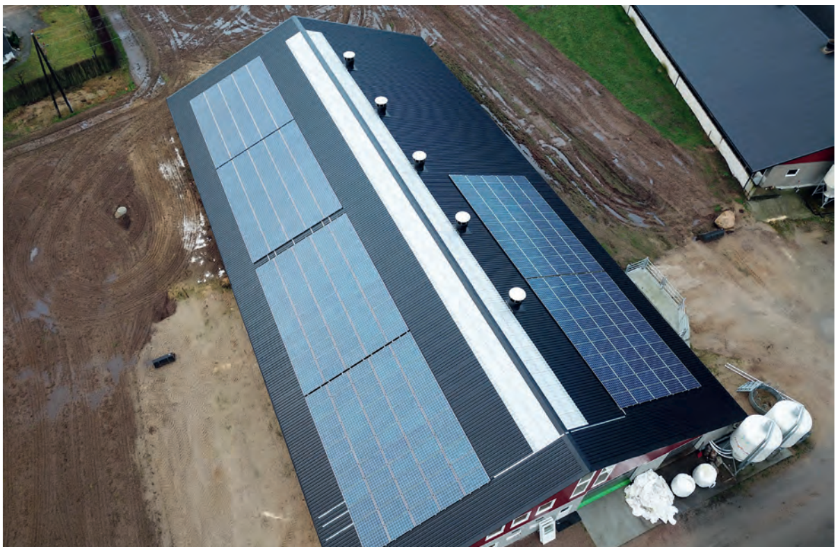
Noen av solcellene ligg mot øst og resten mot vest. Slik kan vi da få utnyttet anlegget hele dagen i steden for å få en høy topp midt på dagen, hvis alt lå rett mot sør. Foto: Kverneland - Energi
