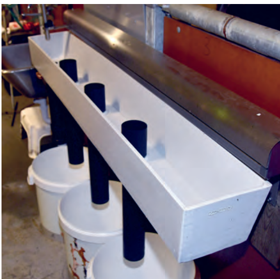
En liten detalj: Renne med sluk og slange for å hindre melkesøl på gulvet ved utskiller. Renna er produsert av Sømna Plast.
