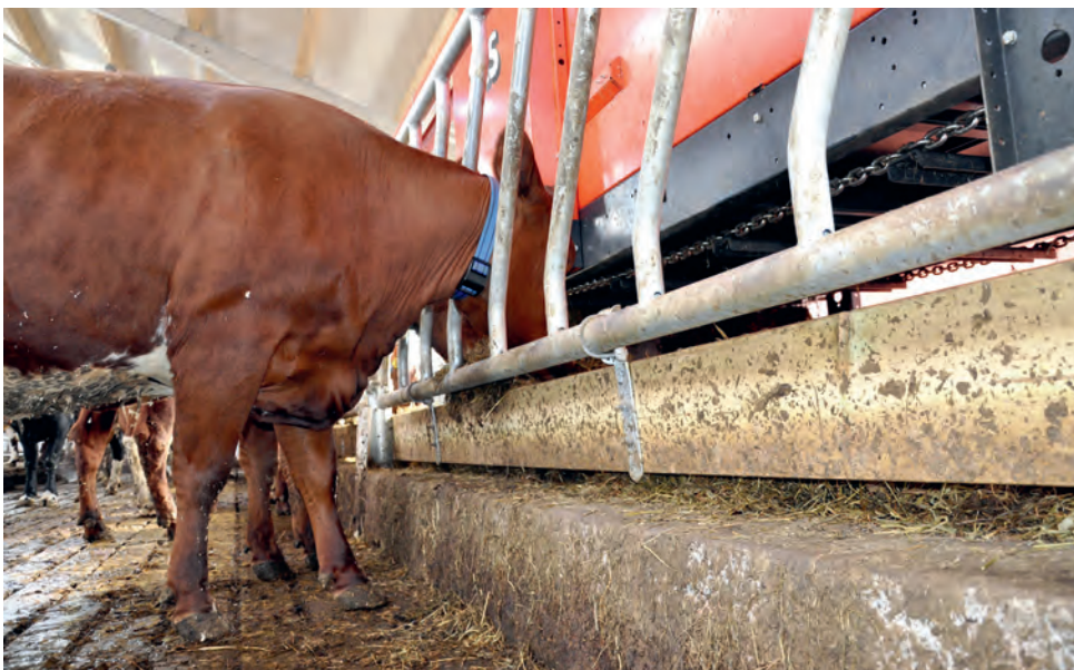
For di fôrbrettet heller ut mot sidene kan fukt sige under båsfronten og ned i gjødselkjelleren.
