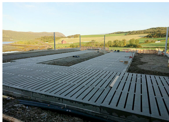
Betongsarbeid med flyterenner og spalter.
