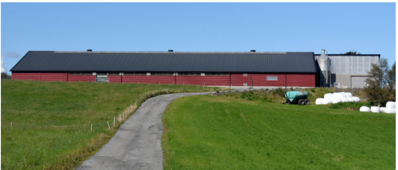
Fjøset fra 2004 ble bygd på med førsentral (til høyre i bildet).
