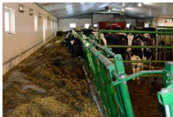
Justering av fronten slik at kyrne når lengre fram er en enkel og rimelig utbedring på reimeinnredningen.
