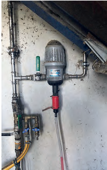
Blander som kobles til vannslange slik at du kan justere syretilsetning prosentvis. Foto: Harald Støyl.
