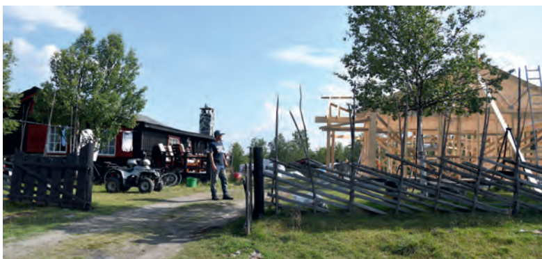
Jon Terje Rying mellom det gamle seterhuset og det nye seterhuset under oppføring. Her er det ingen tanker om å gi seg med setring og alle dyra er med på setra.
