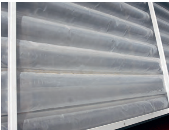
IsoCell-gardinene styres av temperatursensorer og værstasjon.
