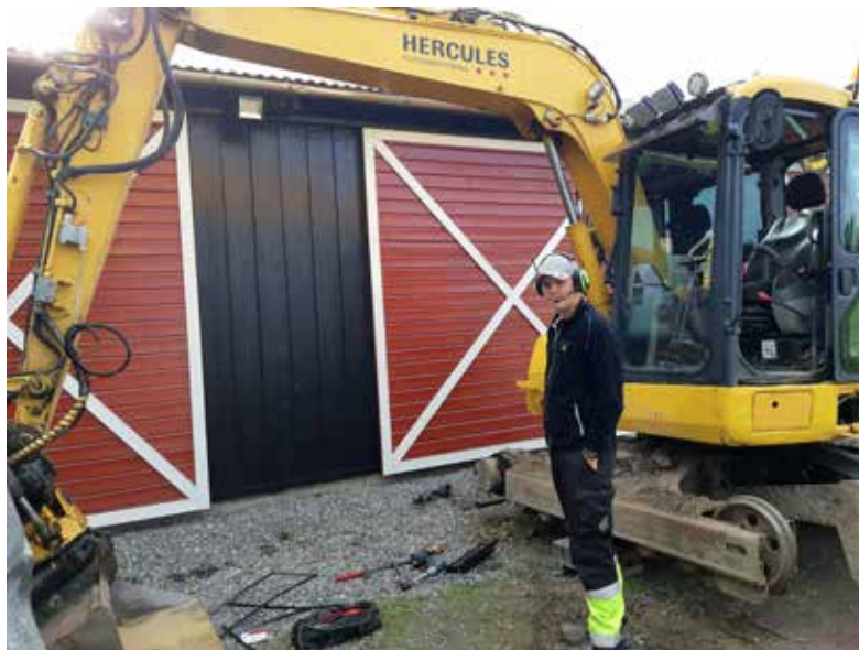
Både gravemaskina og er gull verdt. Hva gjorde vi før gravemaskina? På bildet ser vi eldsteguten Jørgen på snart 20.
