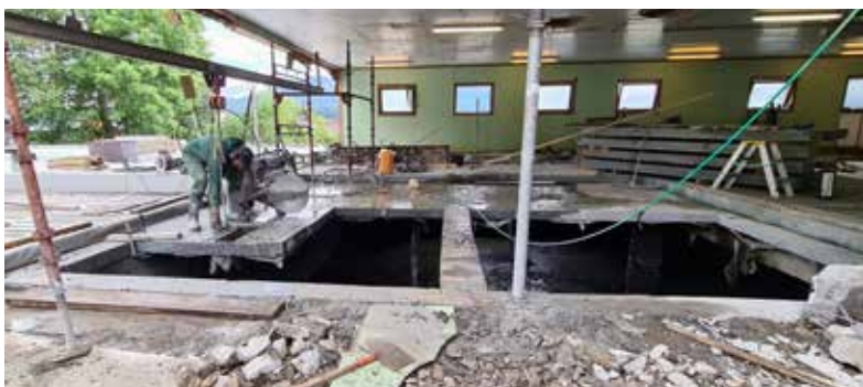
For å få spaltegulv med åpen forbindelse i hele fjøset måtte alt gulv i gamlefjøset skjæres ut.
