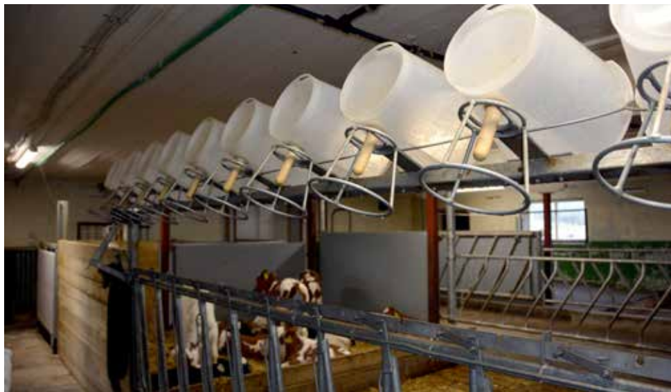
Det er store forventninger til den nye kalveavdelinga etter ombygging av det gamle fjøset.
