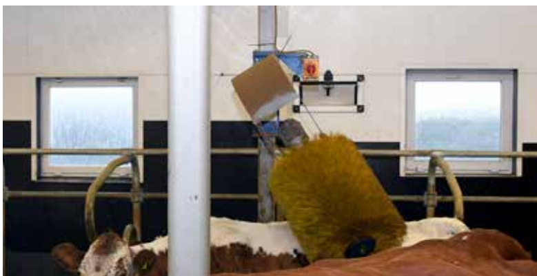
Vinduet til venstre med dugg er i delen av fjøset med flatt tak, mens det til høyre uten snev av dugg er i nydelen med skråtak, vifter i taket og større takhøyde.
