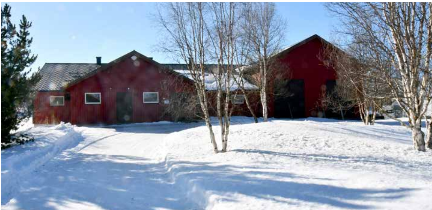
Det nye melkekufjøset vil komme i forlengelsen av dagens fjøs (til venstre i bildet).
