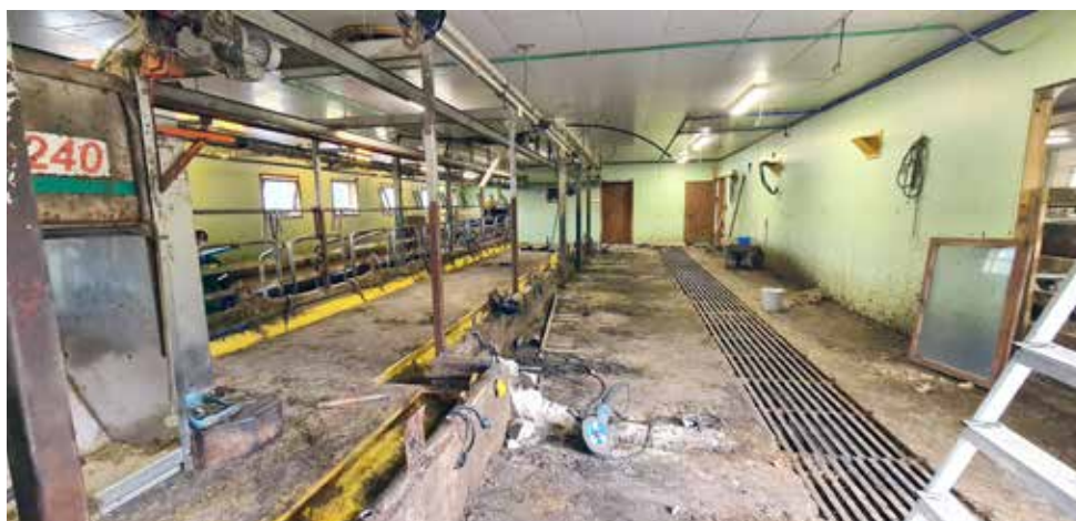
Tilstanden for eksisterende bygninger og hva de kan egne seg til må vurderes. I dette tilfellet ble det gamle båsfjøset kombinert med et tilbygg til et løsdriftsfjøs. Foto: Felleskjøpet
