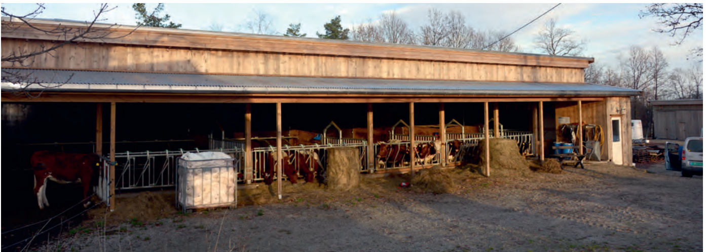
Förbrettet ligger på bakkenivå slik at fôringslinja blir svært enkel.
