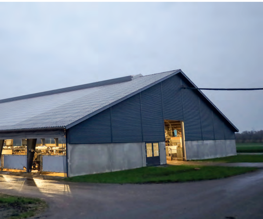
Nyffjøset på Sønder Troelstrup måler 45 x 33 meter. Det er uisolert og kostet 3 millioner Danske kroner i 2019 (4,2 millioner NOK). Her er melkekyr og melkerobot på ene siden av et bredt kjørbart forbrett og kalvingsbinger på den andre.
