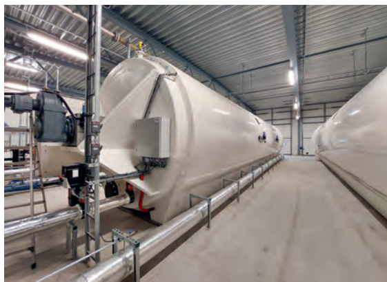
Antek biogass reaktor hos Roar Svanem. Foto Ingvar Kvande NORSØK
