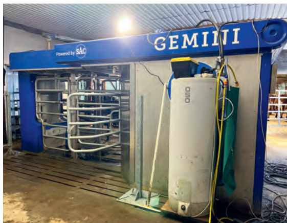
Da roboten ble satt i førsentralen ble det plass til sjuke-/kalvingsbinge på denne siden. Der kan kua gis prioritert og gå ut og inn av roboten og melkes. Roboten fungerer også som kraftfôrautomat.
