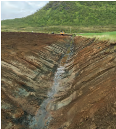
Ferdig gravd kanal.
