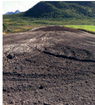
Profil ferdig til såing.
