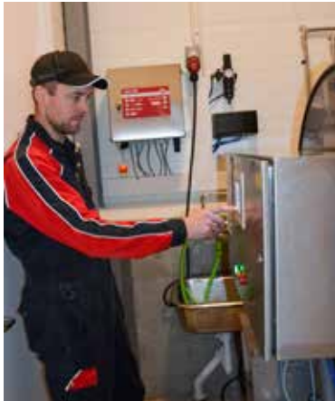
Filterskift tre ganger i døgnet, samtidig som kjøletemperatur sjekkes.
