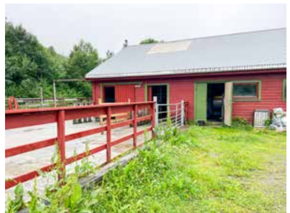
Seterhuset med dør inn til tankrom til høyre. Døra i midten er til melkestallen og døra til venstre leder inn til sjukeavdelingen. I høyre del av bygget er det leilighet til røkterne.
