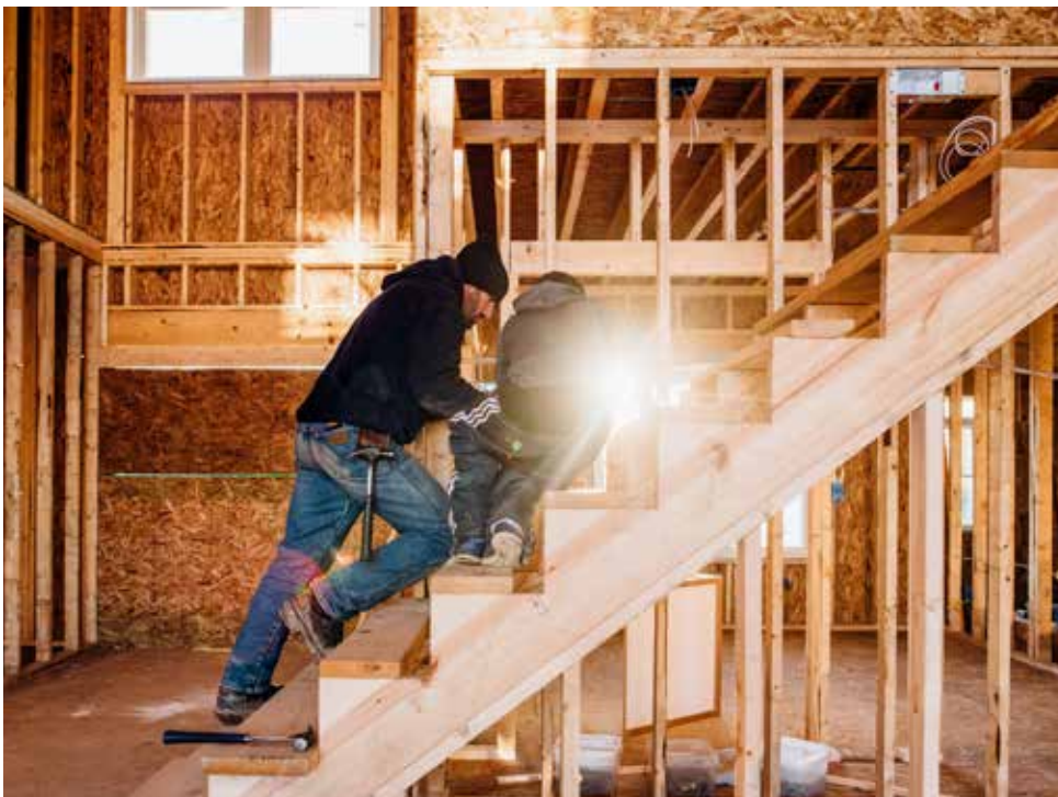
Hvis bygges på noen andres eiendom vil grunneieren som hovedregel kunne kreve at det blir fjernet eller rettet i henhold til naboloven § 11. Det er imidlertid unntak fra denne hovedregelen. Foto: Jumpstory
