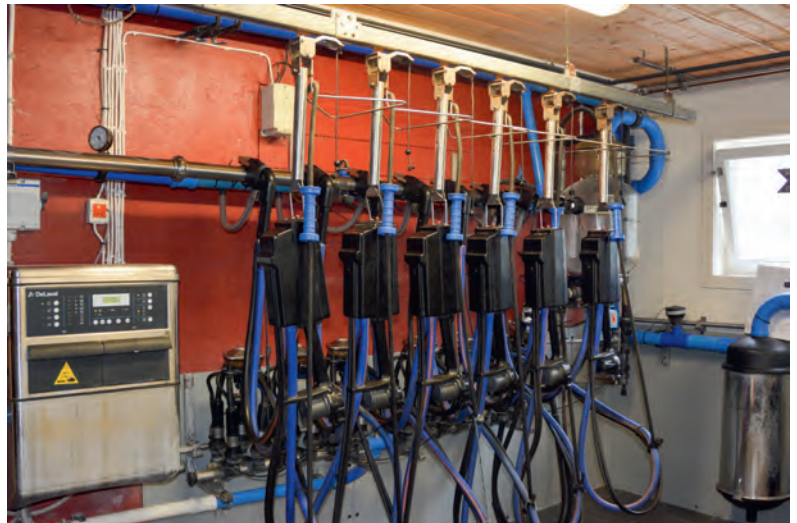
Mjølkerom og renovering av fjøset i 2014.
