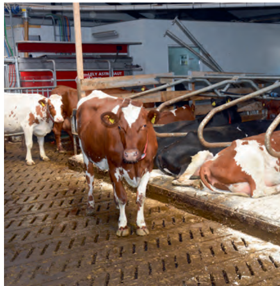
Tverrstilte spalter har et riktigere forhold mellom spaltebredde og -åpning som gir bedre drenering samtidig med en god bæreflate for klauvene. Foto: Rasmus Lang-Ree
