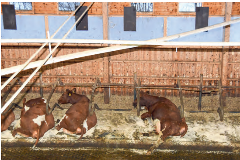
Vindbremsduk i langveggene har blitt erstattet med trevegg og pleksiglass for å unngå kuldegrader i robotene og problemer med gjødselskrapene.
