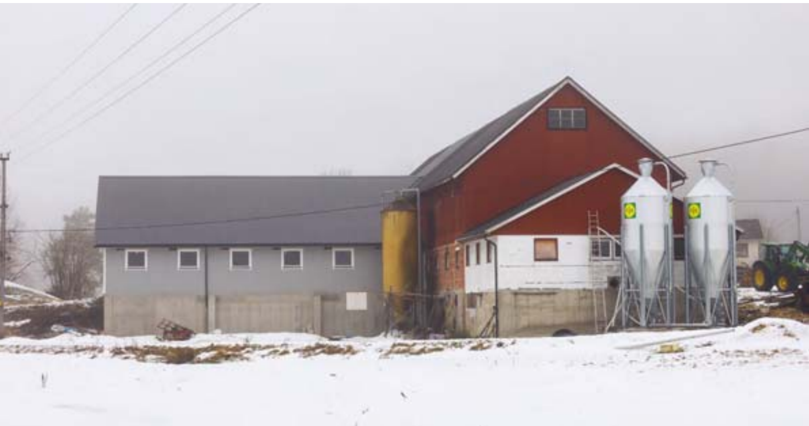
Låven og gamlefjøset er bygd på 330 m 2 med full kjeller. Ombygging/påbygg med robot har kostet ca. 6 millioner. Men et nytt tilsvarende fjøs hadde kostet minst 10 millioner. Det kan se ut som påbygget er i betong, men det er i tre fra egen skog kledd med plater
