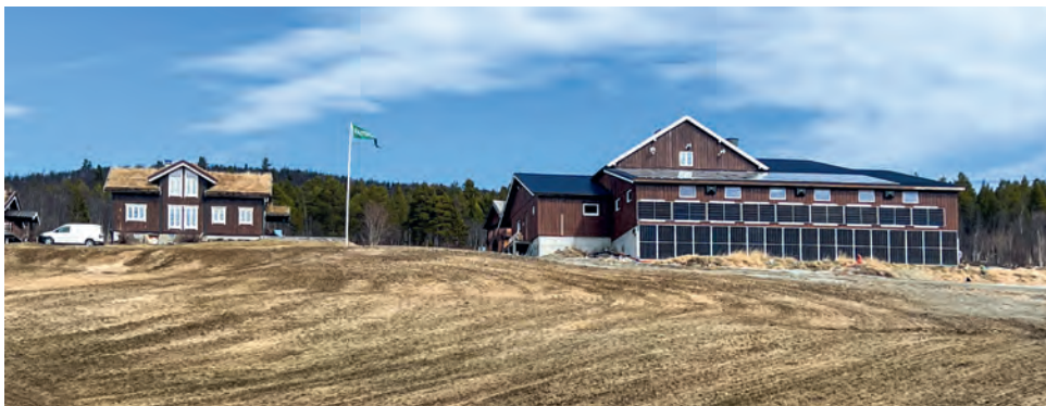
Båsfjøset ble ombygd og påbygd i 2009 og mjølkerobot satt inn. Kreative løsninger med veldig god arealutnyttelse ga et fjøs som fortsatt er rasjonelt og velfungerende. Siden da har det blitt bygd på nytt inngangsparti.
