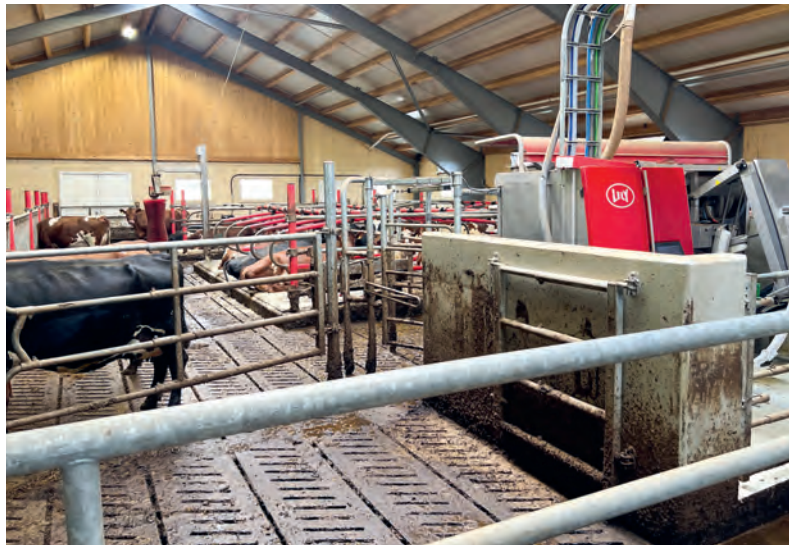
Fjøset er bygd med massivtre i veggene, stålbuer, åser av tre og sandwich-tak. Tre liggebåsrekker på kusida og ungdyrbunger på andre siden av førbrettet. Velferdsavdeling ved roboten.
