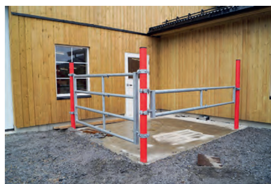
Egen utlastningsbinge i hjørnet ved fjøskontoret. Dette for å hindre at slaktebilsjåføren må inn i fjøset. Bingen har varmekabler så den ikke er full av is/snø ved dyrehenting om vinteren.
