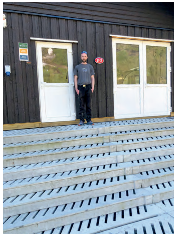
Den mykje omtalte trappa på Veitastrand. Gjenbruk er i vinden for tida, og Knut Fredrik har brukt skada spalteplass til å byggja opp trapp i inngangspartiet.
