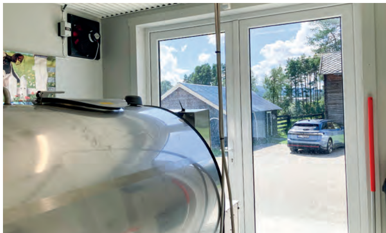
I 2024 ble det bygd påbygg på fjøset (350 m 2 ) inkludert nytt tankrom/smittesluse. Rørmjølkeanlegget ble byttet til et brukt mer moderne anlegg med avtakere.
