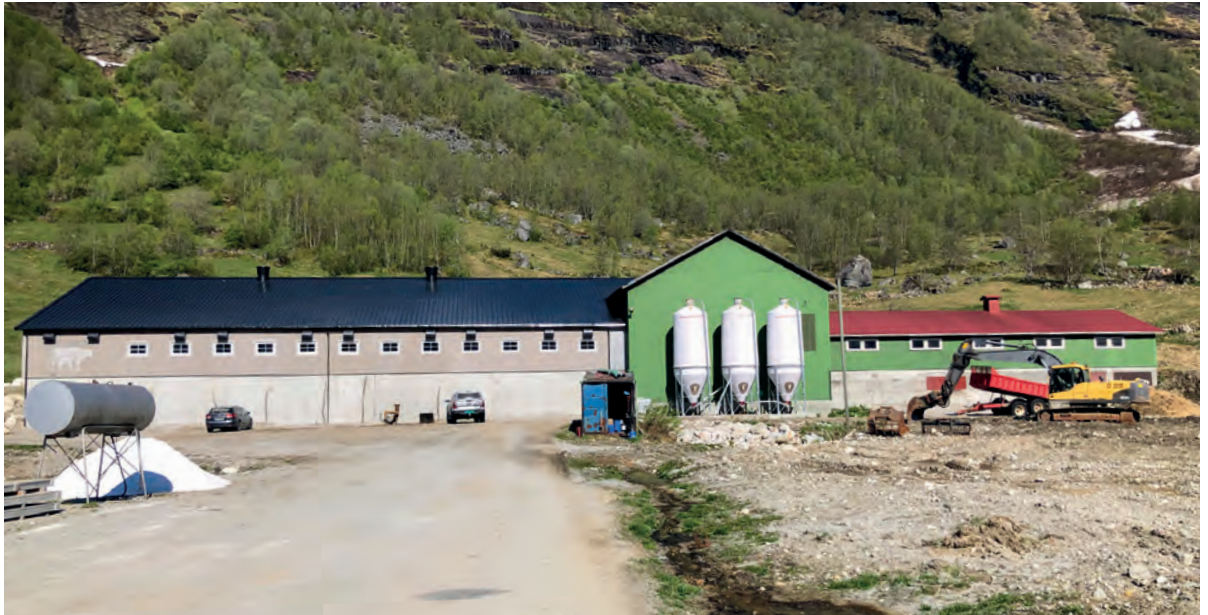
Veitastrom sin største fjøs tilhører Nedre Heggestad samdrift. Nybygg til venstre og gjenbruk av førsentral og silo. Den eldre delen skal truleg byggjast om til oksefjøs.
