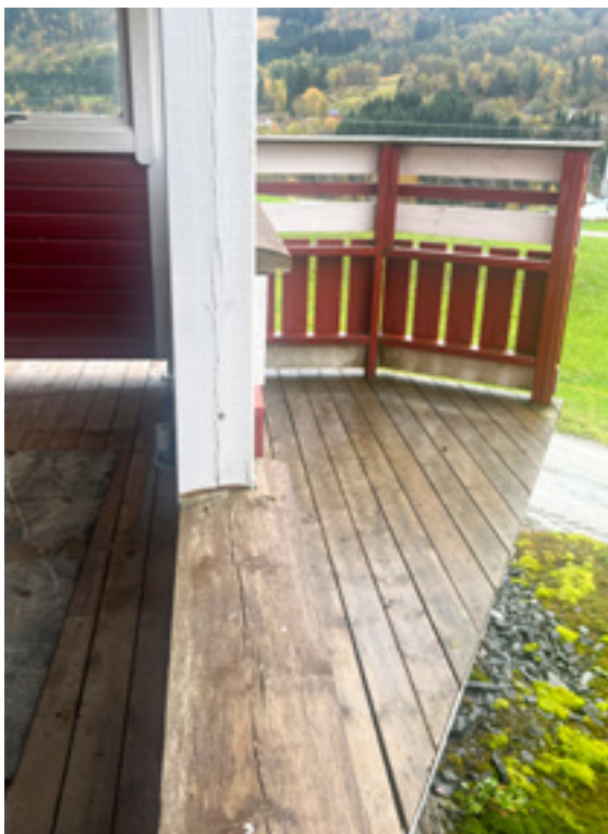
Utlastingsrampe som dyretransportbilen kan rygge inn til. Fjøset er også planlagt slik at det skal være enkelt å vinsje ut ei død ku.
