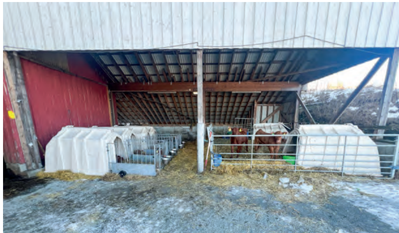
Kalveavdeling under et overbygg ved driftsbygning løste kalvehelseproblemene.
