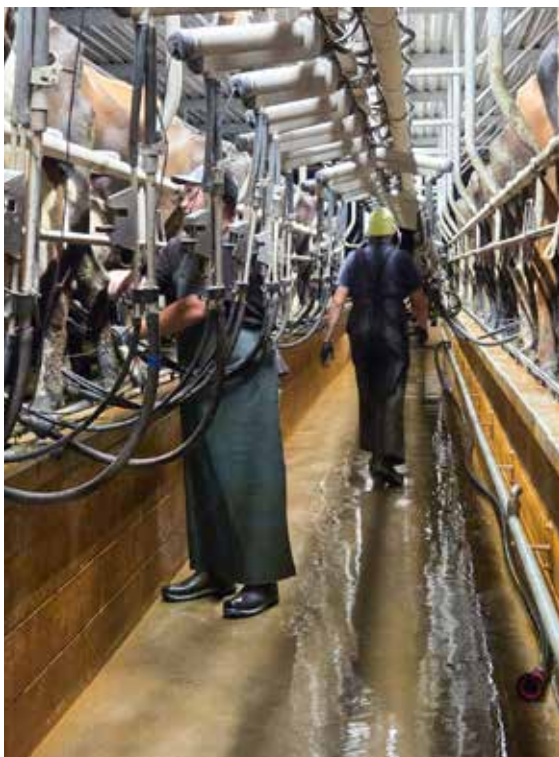
Melkegrav – midtmontert 2x40 fiskebeinstall med påsett i 50 graders vinkel.
