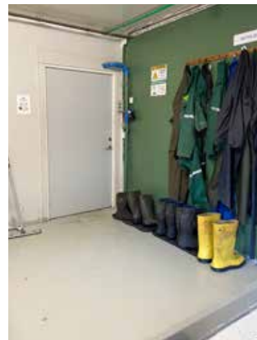
I det gamle mjølkerommet har familien laga ei original og fin smittesluse. Når ein trakkar opp på forhøgninga er ein i rein sone. Det er også varmekablar i golvet i slusa.
