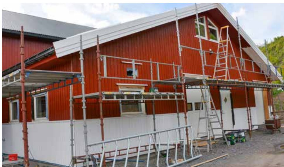
Påbygget er på i underkant av 90 m 2 og rommer kalveavdeling, tankrom, smittesluse, kontor og flisrom.
